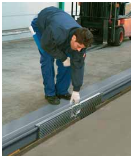
Извлечение моста из направляющей рельсы
